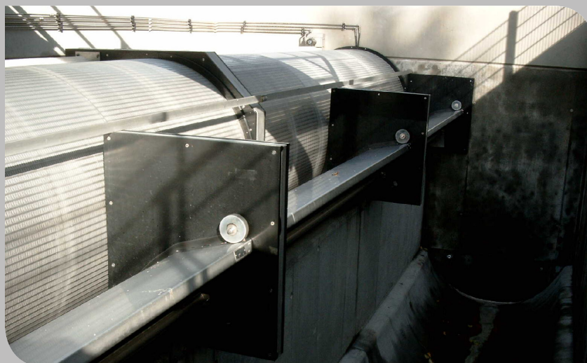
Figure 2 : L'utilisation du déversoir flexible HYDROVEX® BW pour l'optimisation hydraulique
