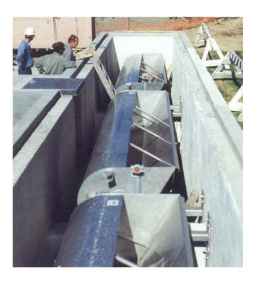
La cuve basculante **HYDROVEX**® **SFT** est construite en acier inoxydable de section circulaire et est pourvue d'un bec verseur. Reposant sur des roulements étanches, elle peut basculer autour de son axe de rotation.
