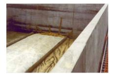
• L'eau utilisée pour la cuve basculante **HYDROVEX**® **SFT** peut provenir de l'aqueduc, du bassin de rétention ou de toute autre source d'eau. Le remplissage de la cuve peut se faire manuellement ou automatiquement.
