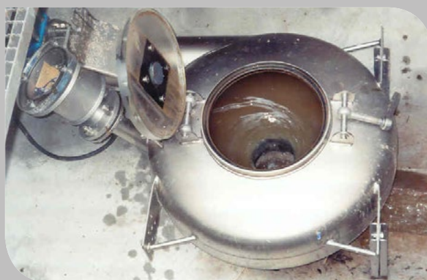
Figure 3 : HYDROVEX® HHV-E en fonctionnement. Le couvercle est ouvert pour l'inspection
